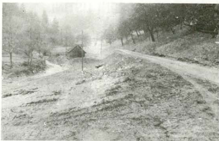
Stanje po sanaciji hudournika Velunje. Na tem mestu po neurju ni bilo ceste
