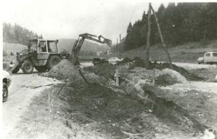
Izgradnja šolskega igrišča pri osnovni šoli Sele
