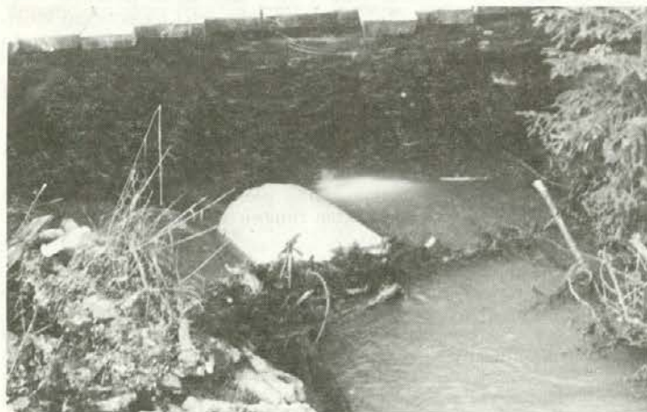
Cev iz odnešenega propusta v Strgarjevem grabnu
