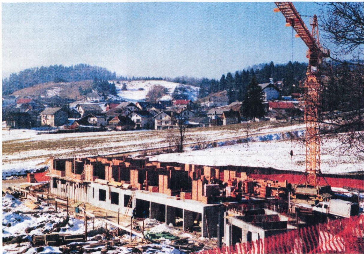
Gradnja Doma za ostarele v Grapočniku (na fotografiji) dobro napreduje kljub mrzlemu zimskemu vremenu. Prav tako dobro teko dela pri gradnji vrta v Gornjem Logatcu, kjer se stekajo priprave za betoniranje prve plošče. (Foto: F.B.)
