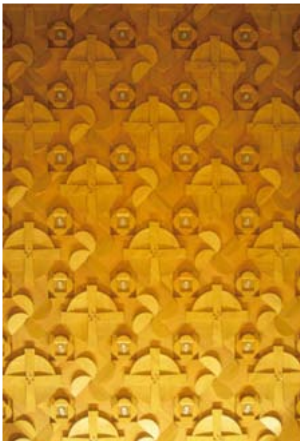
Slika 2: V oblikovnem pogledu gradijo strop variirani motivi križa, ki jih členi mreža svetlobnih "cvetov". S tem, ko so svetila vgrajena v samo stropno oblogo, ostaja lepo proporcionirana prostornina glavne ladje neokrnjena. Gosta mreža svetil pa le-to povsem presvetli in stopnjuje njeno monumentalnost.
