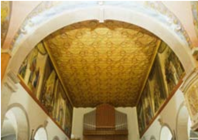
Slika 1: Prenova župnijske cerkve sv. Martina pri Fari. Izvedba novega stropa v glavni ladji. V tehničnem pogledu je nov strop zasnovan kot obešen strop, ki je pritrjen na obstoječo pravokotno mrežo tramovja tako, da jo s spodnje strani v celoti zapira. S tem je po eni strani zaprt pogled na nekvalitetno in na določenih mestih že poškodovano tramovje, po drugi strani pa taka rešitev omogoča členitev novo nastale površine v ritmu poslikanih polj na bočnih stenah ladje oziroma v ritmu arkad med ladjami.
