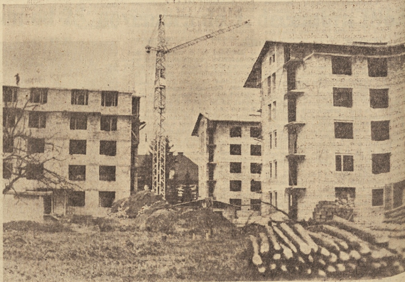
SGP Gorenje Radovljica — gradilišče v Kranju
