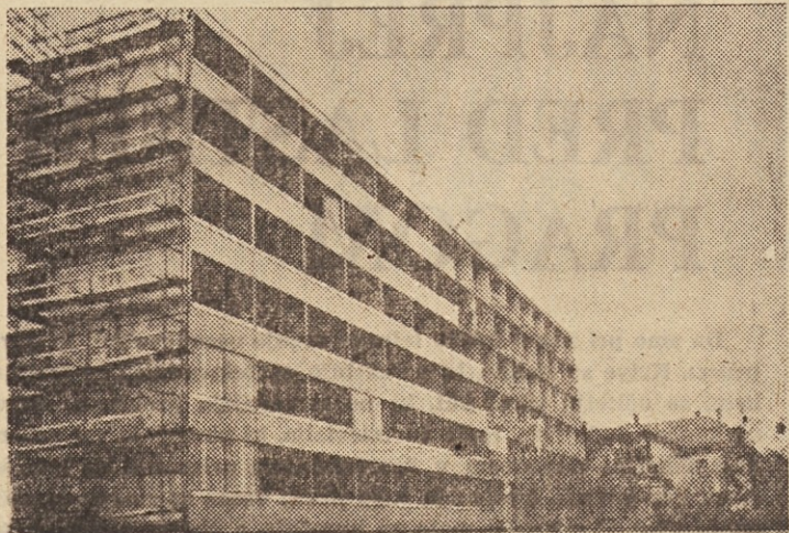
Montažni blok s 56 stanovanji tipa »Jugomont«
