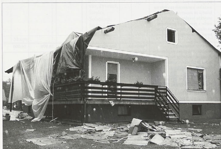
Popolnoma brez strehe nad glavo so ostali tudi Vrablovi na Sp. Hajdini. Hiša je imela novo ostrešje, ki pa ni vzdržalo pod sunkom orkanskega vetra.
