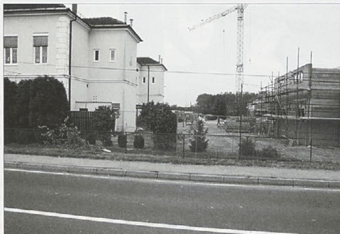
Delavci podjetja GP Project ing delajo s polno paro.
