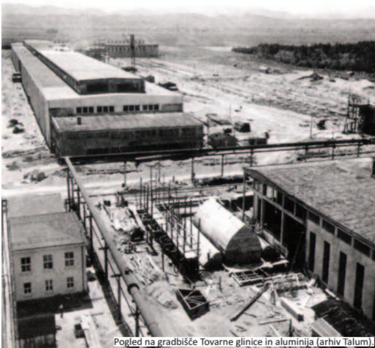
Pogled na gradbišče Tovarne glinice in aluminija (arhiv Talum).
