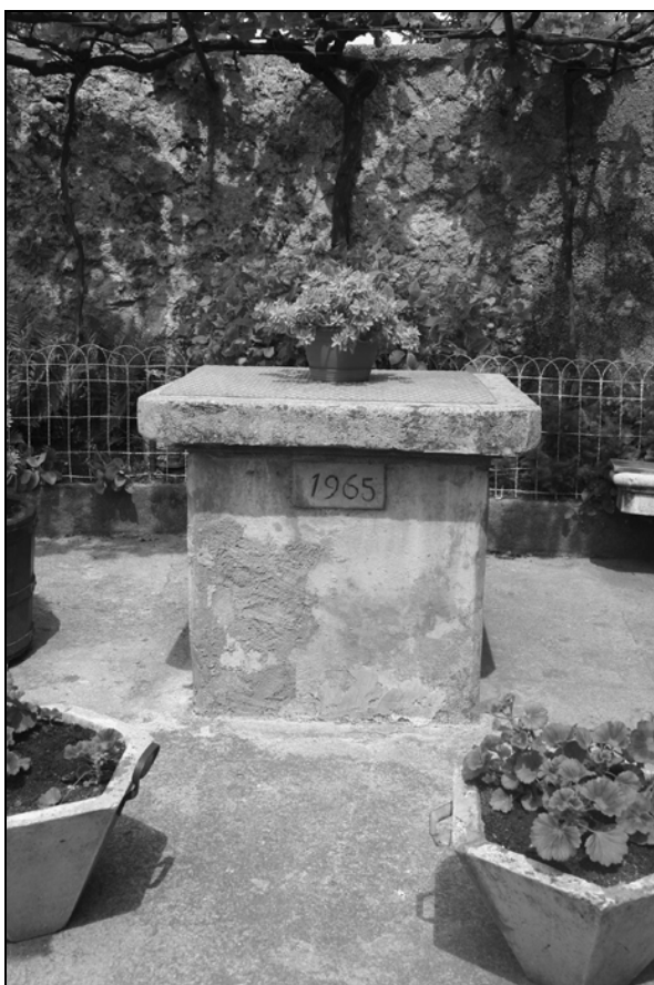
Lukceva štirna, Dane 14. Tudi Lukceva štirna je imela zidan kamnit oklep, ki pa se je z leti razmajal. Po modi takratne, cementne dobe, je stric sedanje gospodinje Marije Škrlič, Alojz Felicijan, leta 1965 oklep skoraj do tal podrl in naredil betonskega, kot je to storil v tistih letih še marsikateri drugi gospodar v Danah. Nekateri so oklepe kar podrli in odprtino podzemne cisterne na nivoju tal prekrili (foto: E. Belingar, 2007).
