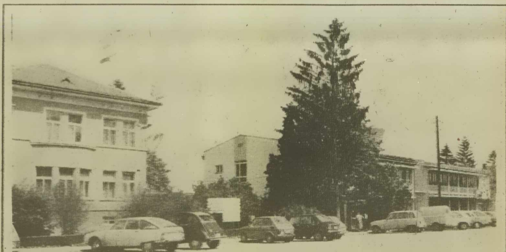
STARA IN NOVA ZGRADBA ZDRAVSTVENEGA DOMA V MURSKI SOBOTI.
