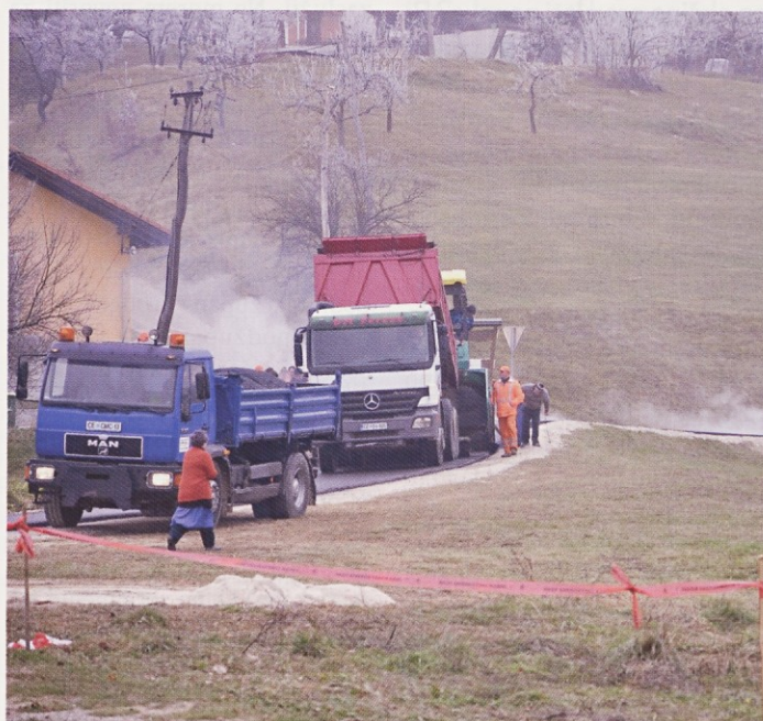
Asfaltiranje ceste proti Uršuli.
