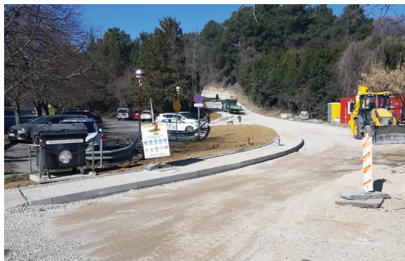
Dela na Vinogradniški cesti. / Lavori in Via dei Vigneti. (Foto: Občina Ankaran / Comune di Ancarano)
