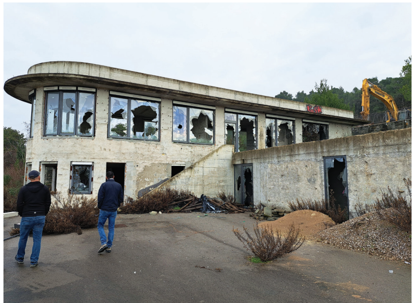
Betonski objekti, namenjeni apartmajem, bodo šli na smetišče zgodovine. / Finalmente demoliti gli edifici destinati agli appartamenti. (Foto: Občina Ankaran / Comune di Ancarano)
