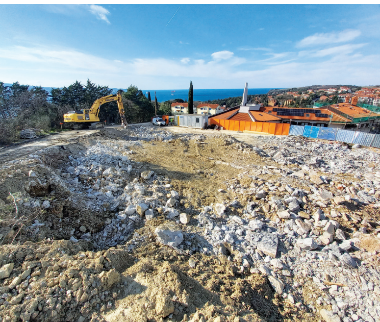
Zaključena so rušitvena dela, sledijo gradbena. / I lavori di demolizione sono terminati, seguiranno i lavori di costruzione. (Foto: Občina Ankaran / Comune di Ancarano)
