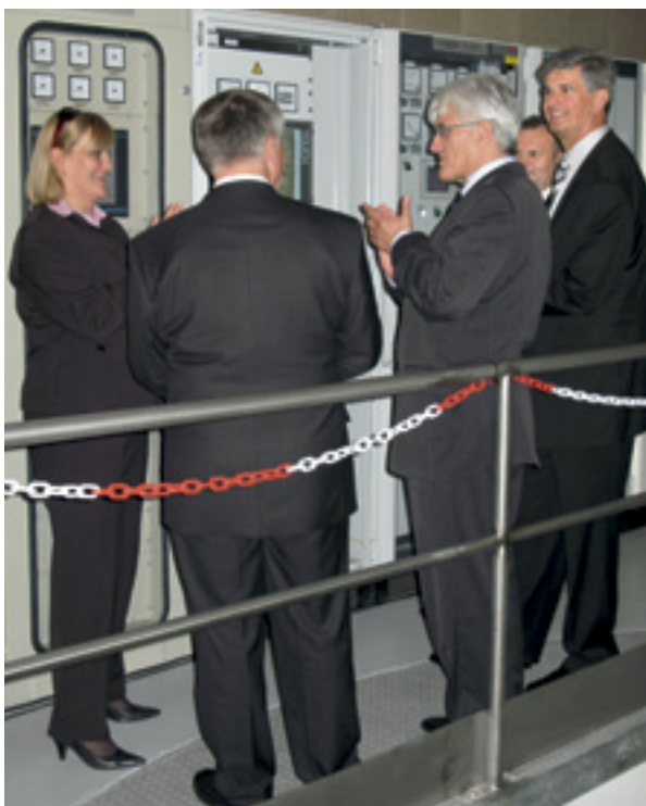
Zagon prenovljene strojnice HE Moste sta uradno opravila ministrica za gospodarstvo mag. Darja Radić in minister za okolje in prostor dr. Roko Žarnić.
