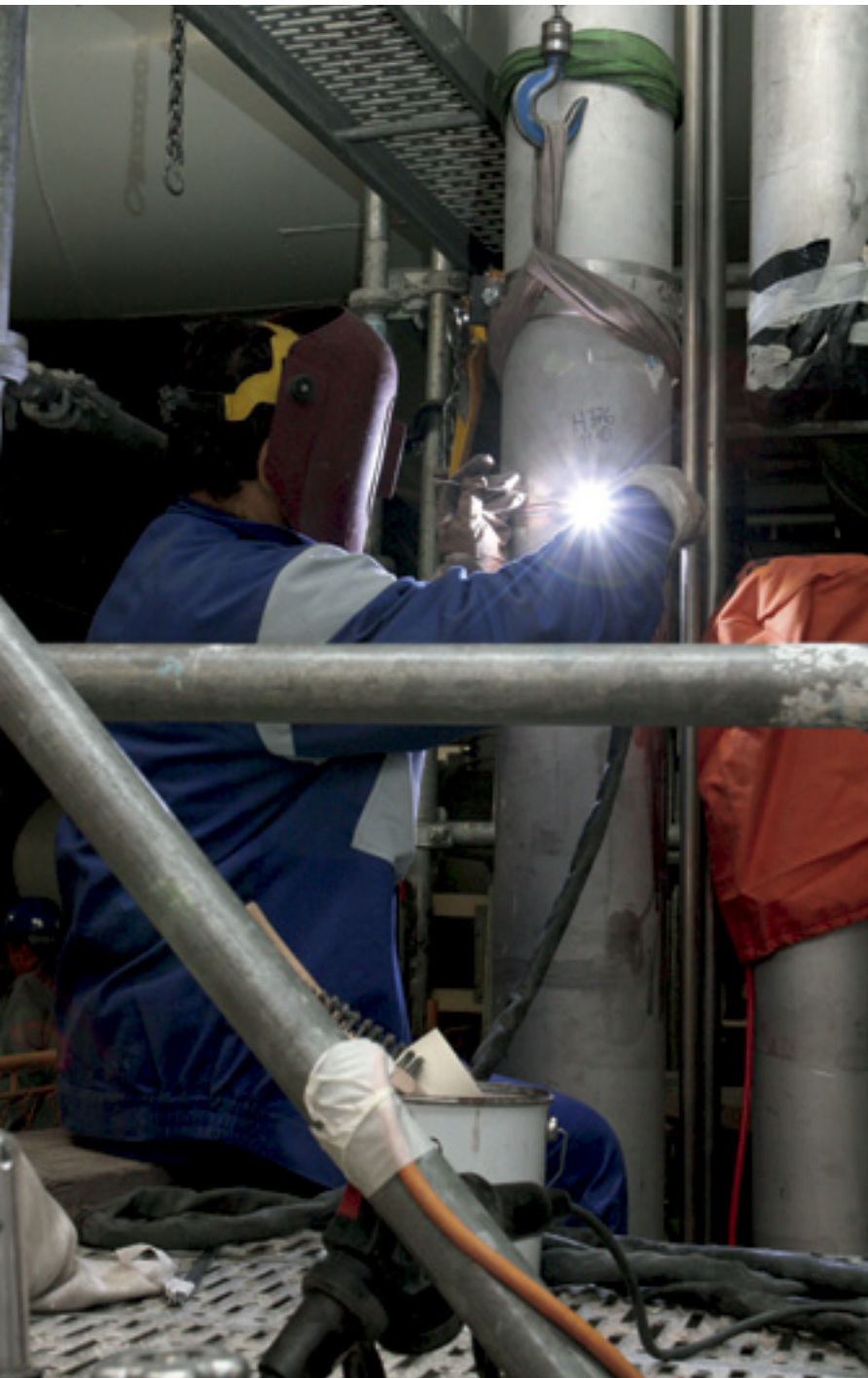
Delavec pri varjenju.
