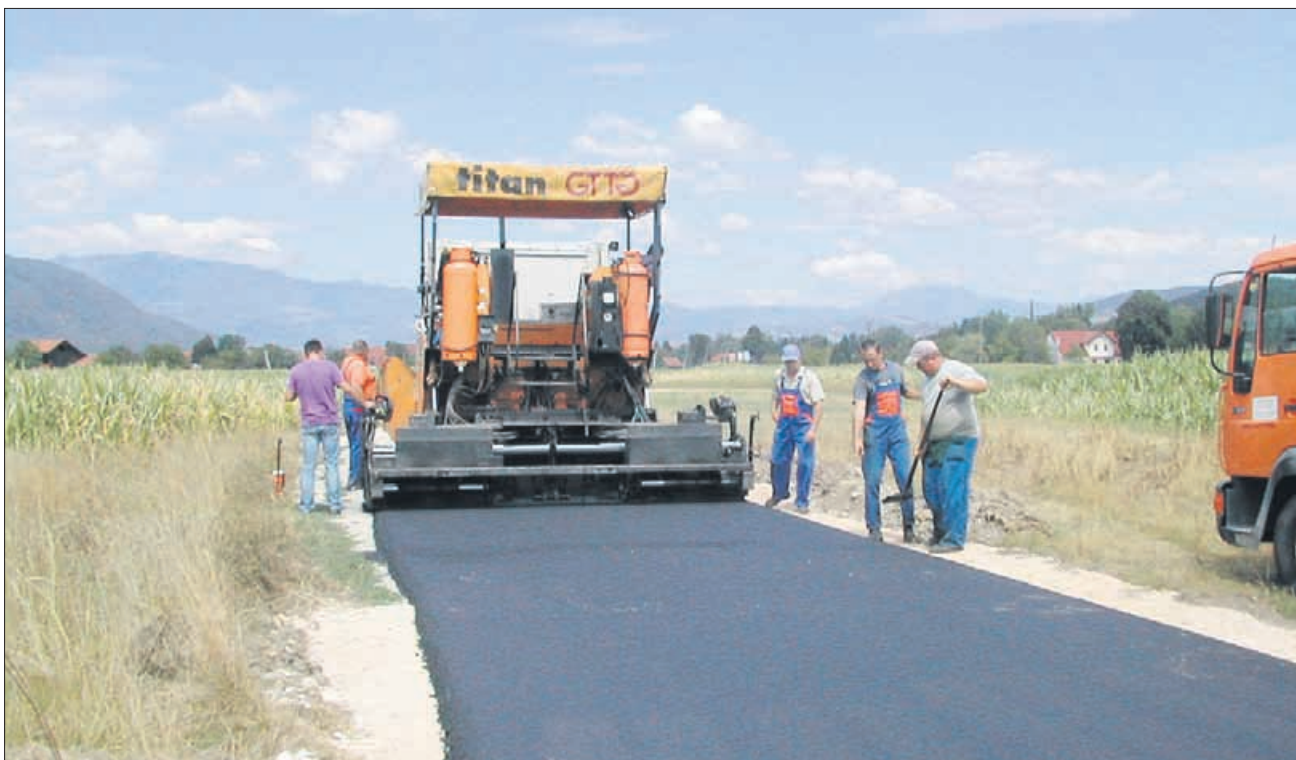
Pri asfaltiranju na cesti Parižlje-Preserje
