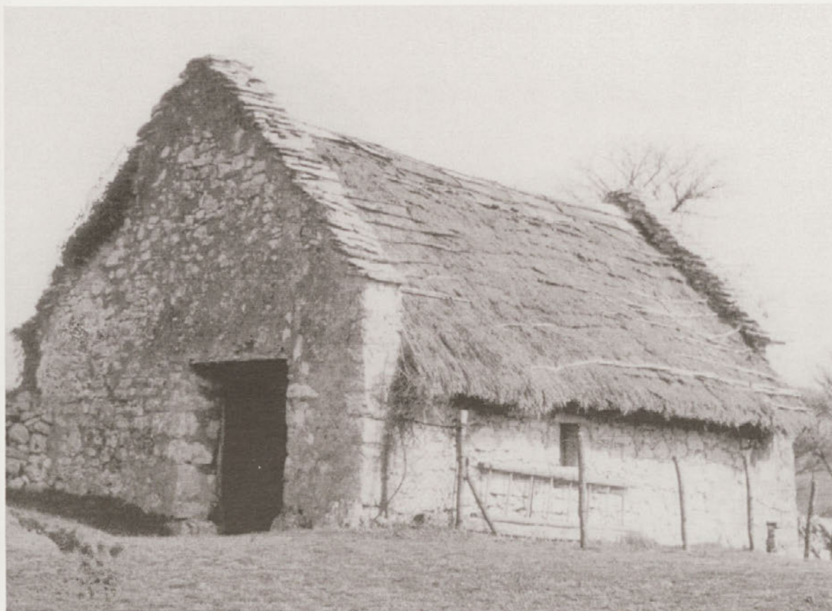
Jakopinov skedenj pred obnovo.
