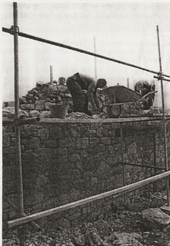
Obnova zahodne fasade
