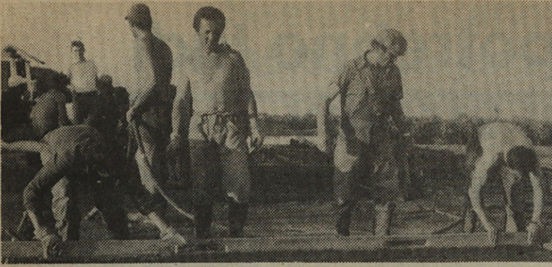
Celotna količina betona za ploščo na mostu preko Tigrisa je bila vgrajena s pomočjo črpalke Scheele. Površino betona smo zaščitili s pobrizganjem »Kontrasola«, kar se je pokazalo kot povsem zadovoljivo brez posebne dodatne nege. Na sliki je niveliranje in zaglajevanje betona. Konec marca 1981.
