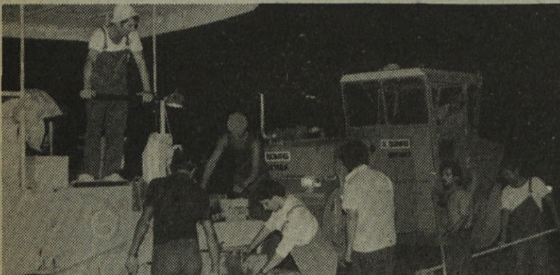
S polaganjem cementne stabilizacije smo pričeli 27. avgusta 1980. Zaradi visoke temperature, tudi preko 50 stopinj Celzija v senci, smo delali le v nočnem času. Žal smo morali v septembru dela prekiniti zaradi vojaških akcij
