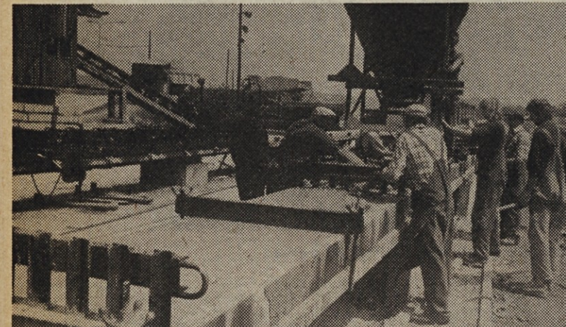
Izdelovanje hlevskih montažnih gredic
