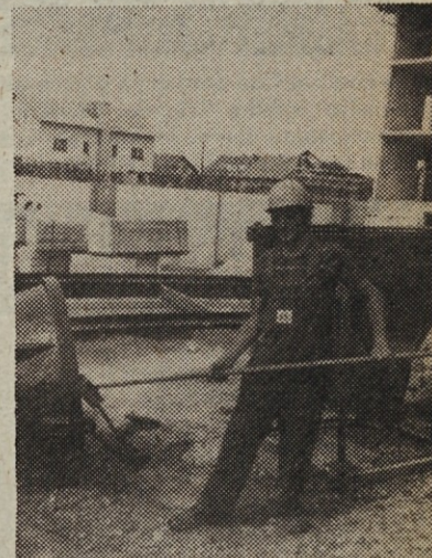
Vzdrževanje posode za prenos betona in premaz z oljem lajša delo betonarjem, pravi Mladen Stojinović iz Maribora
