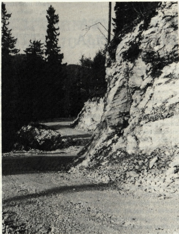
V velikih strminah so ceste drage in slabo služijo svojemu namenu. Foto: Z. Š.
