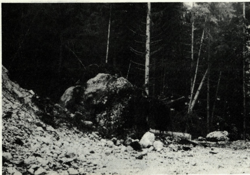
Umiranje brežin ob novozgrajenih cestah
