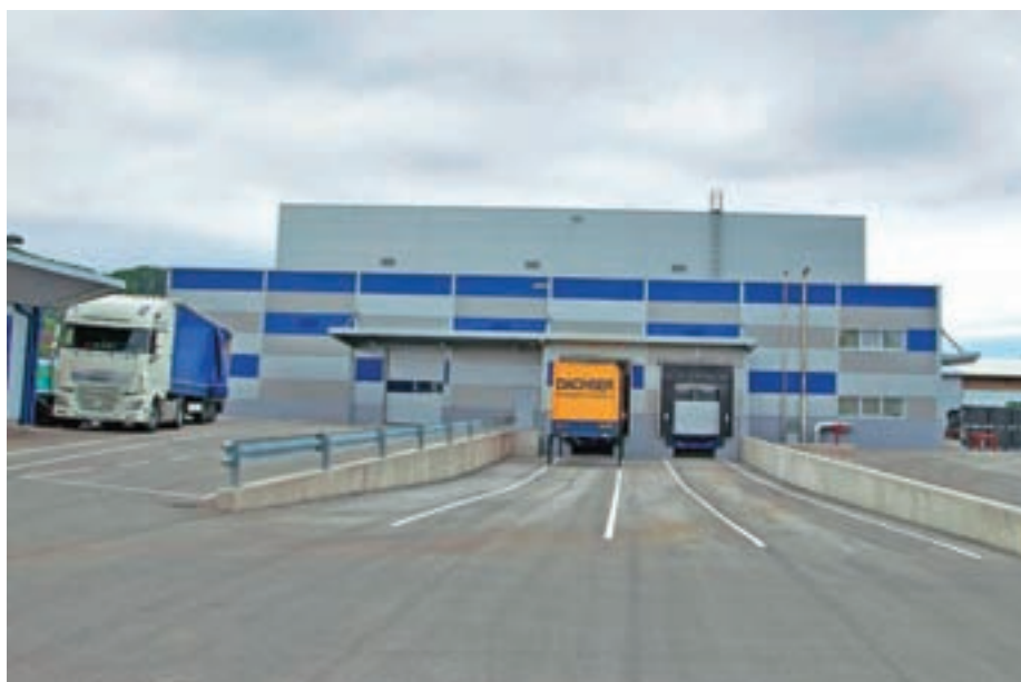
Zunanja podoba novega Heliosovega skladišča na Preski
