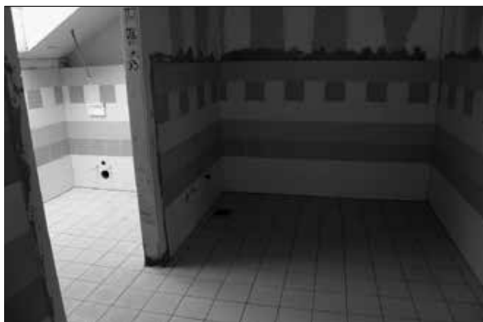
V notranjosti so že položene ploščice.
