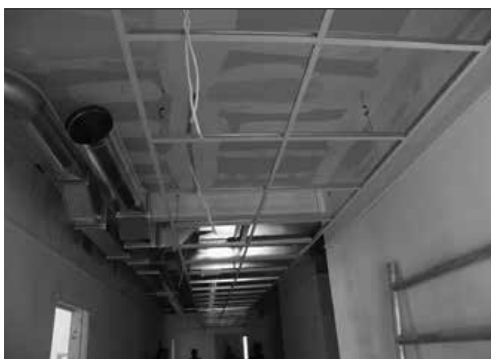
Izvajajo se zadnja instalacijska dela.
