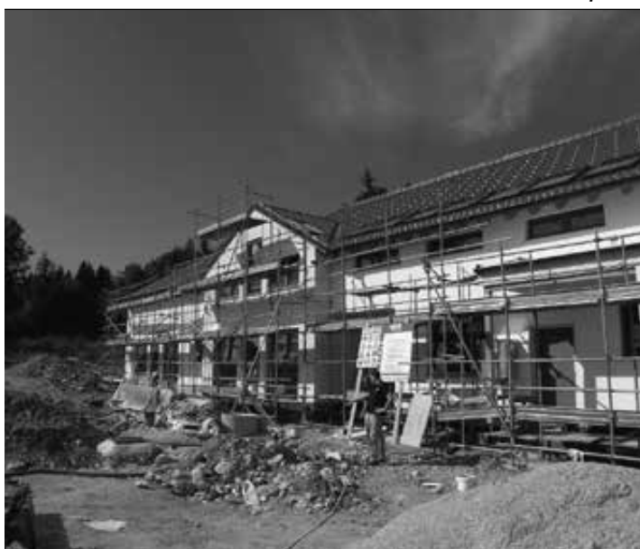
Pročelje dobiva končno podobo.
