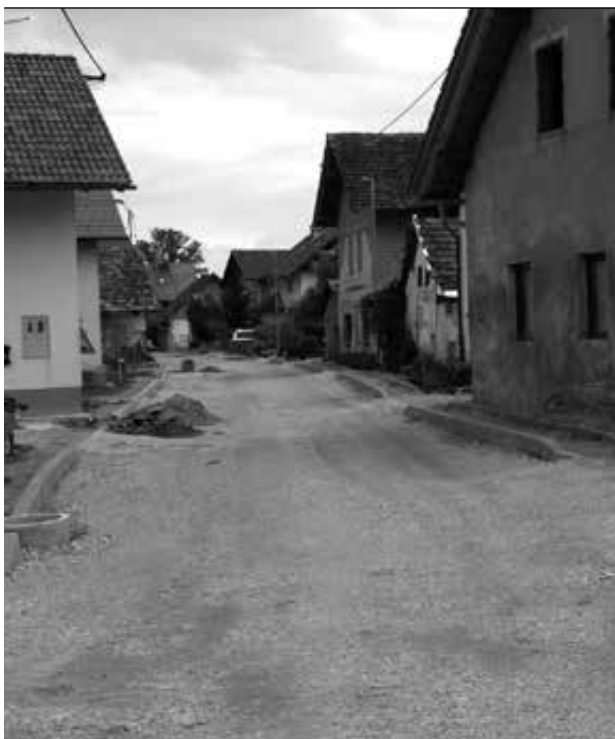
Priprava ceste za asfaltiranje
