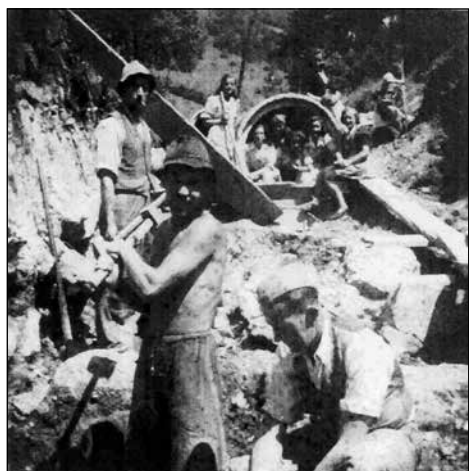
Gradnja cevovoda na fotografiji: levo Šuštar Ciril, spredaj Torkar Jože, desno Dolenc Anton zadaj ostale delavke Nika.
