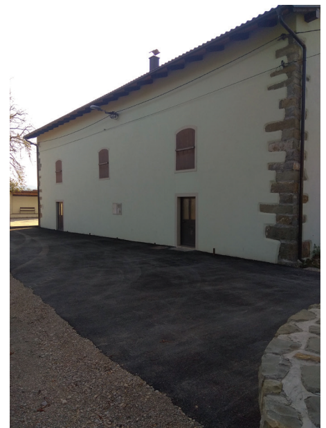
Asfaltirano dvorišče pred dvorano
