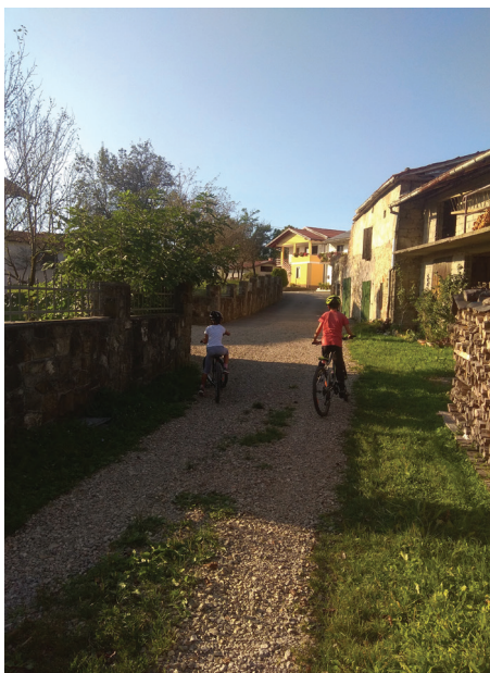
Zamenjana cev in popravljena pot proti Kovačovəmə stədjencə
