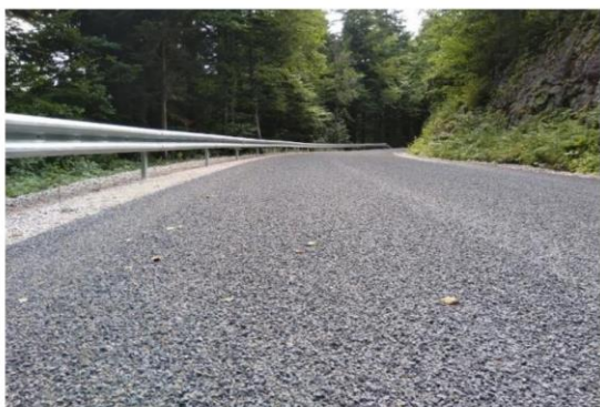
Slika 8 – dvoplastna površinska prevleka s predhodnim posipom; R3-746, odsek 2407 Stari trg – Loški potok od km 2.020 do km 7.500
