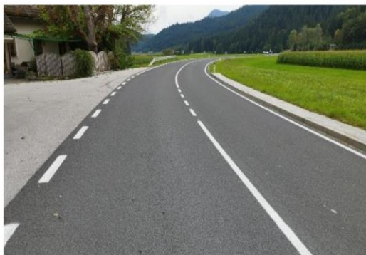
Slika 5: Enoplastna površinska prevleka 4/8 mm; R2-403/1076 Češnjica -Škofja Loka
