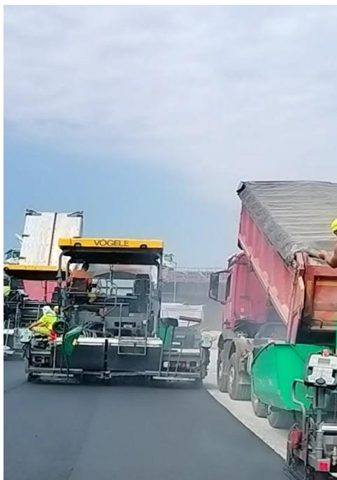
Slika 8: Vgradnja SMA 11 PmB 45/80-65 A2 (HMA)
