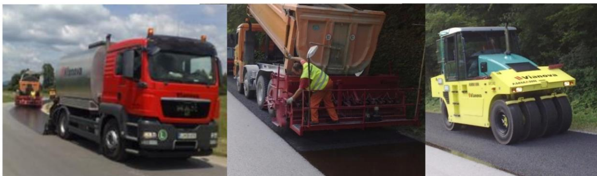
Slika 3: strojna izvedba površinske prevleke – pobrizzg, posip, valjanje
