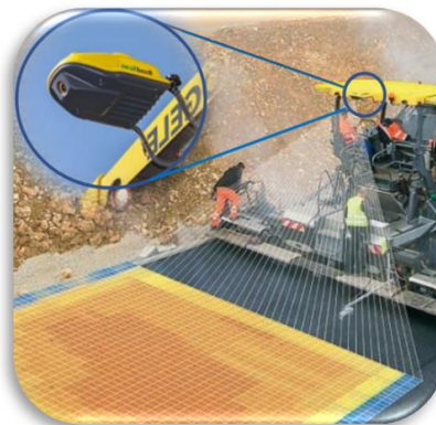
Slika 6: Temperatura asfaltne plasti za finišerjem (levo rezultati, desno meritve s termoskeniranjem); (Rošar, 2020)
