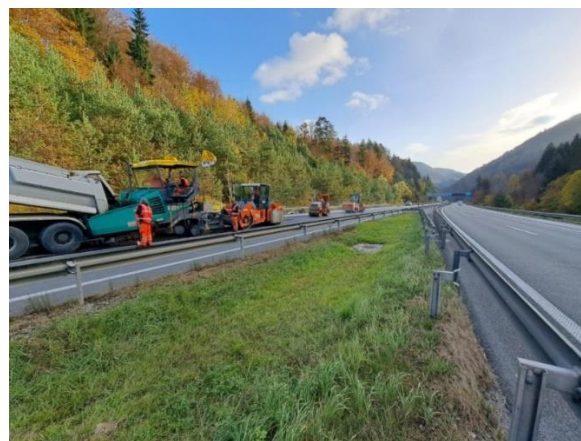
Slika 2: Vgradnja toplega asfalta po postopku penjenega bitumna [TPA, 2024]
