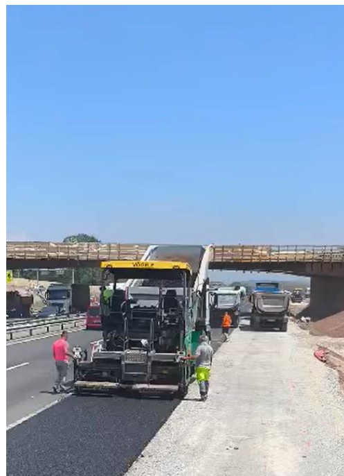
Slika 2: Vgradnja SMA 11 PmB 45/80-65 A2, NT (WMA)
