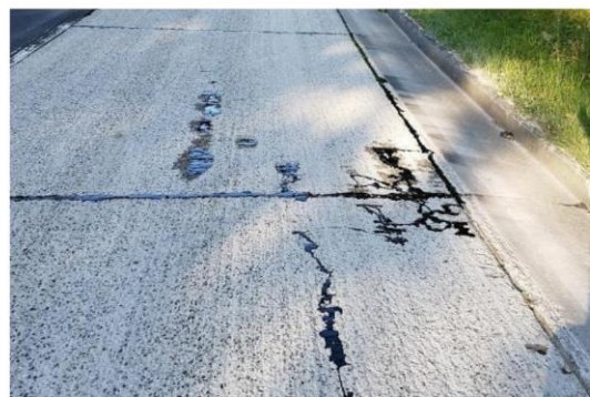
Slika 6: Nahrapavljeno in sanirano betonsko vozišče pred izvedbo protizdrsne prevleke; G1-11/1062 Koper-Dragonja
