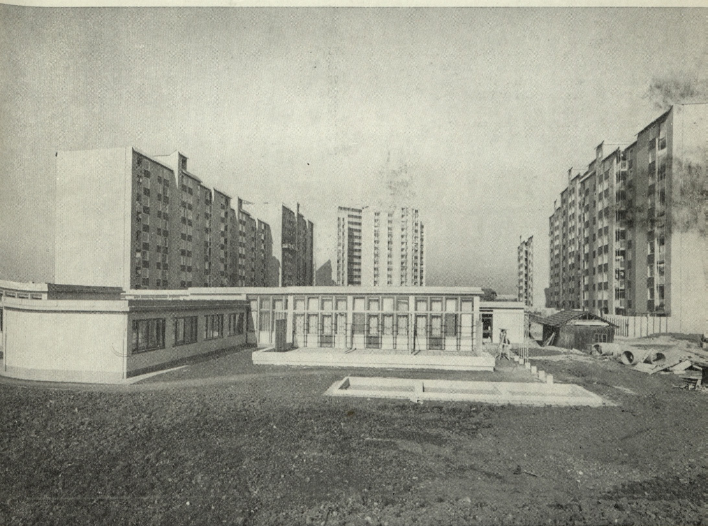
POSLOVNO ZDRUŽENJE GIPOSS: Gradnja stanovanjske soseske S 6 v občini Ljubljana-Šiška. (Projekt nagrajen z nagrado Prešernovega sklada.)
