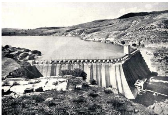
Slika 4 • Pogled na pregrado Cheurfas v Alžiriji, zgrajeno leta 1882 (Barrage – Cheurfas, 2009) (levo), prečni prerez skozi masivno pregrado (Wilson, 2008) (desno)
