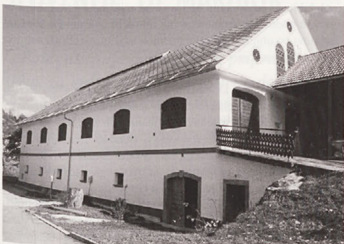
Posavcev hlev v Gorenji vasi po obnovi. Foto: Damjana Pediček - Terseglav, 2003
