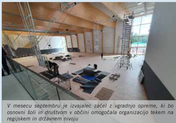
V dvorani so se v času šolskih počitnic zaključevala inštalacijsko-obrtniška dela, položili so parket in vgradili tribune
