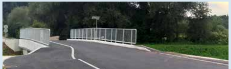
Za varen prehod pešcev sta urejena pločnika in postavljena ograja
