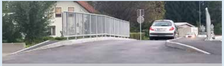
Promet na mostu čez Pšato v Topolah na cesti Mengeš–Vodice zaradi potrebe po ureditvi varnega prehoda za pešce še naprej poteka po enem pasu
