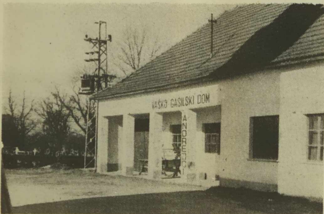
Vaško-gasilski dom v Andrejcih skrbno vzdržujejo, kmalu ga bodo razširili, ob njem pa so že postavili transformator.
