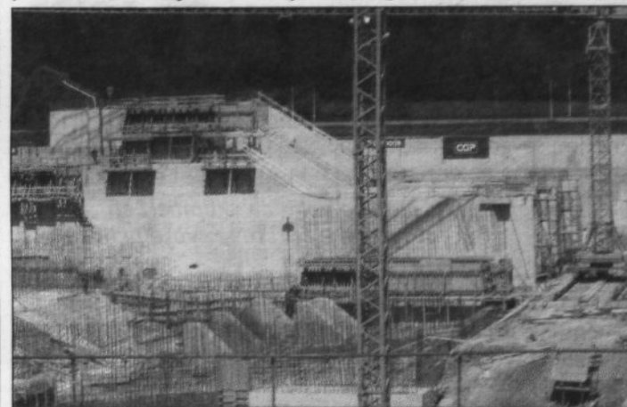
Gradbišče HE Blanca
