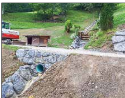
Območje plazu po izvedenih sanacijskih delih (fotodokumentacija Občine Solčava)
