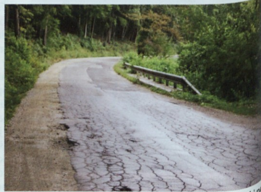
Na odsekih ceste Dole–Ponikva–Loče bodo, dokler odseki ne bodo prišli na vrsto za temeljito rekonstrukcijo, potekala obnovitvena dela.
