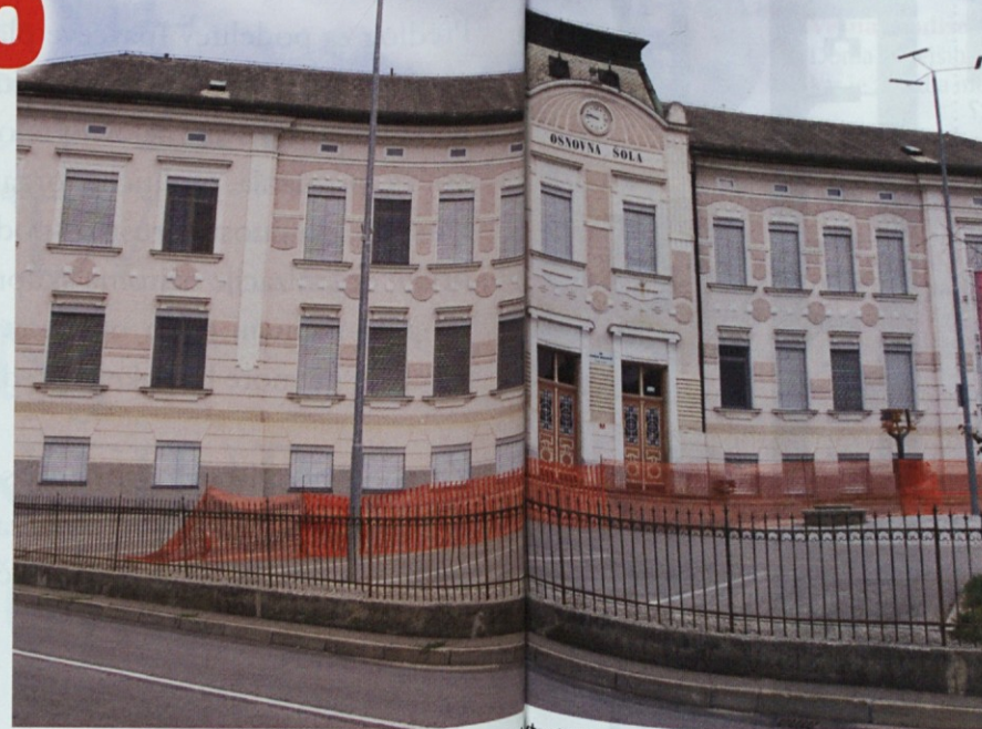
Po energetski obnovi novega dela šole bo zdaj stari del dobil novo streho.
