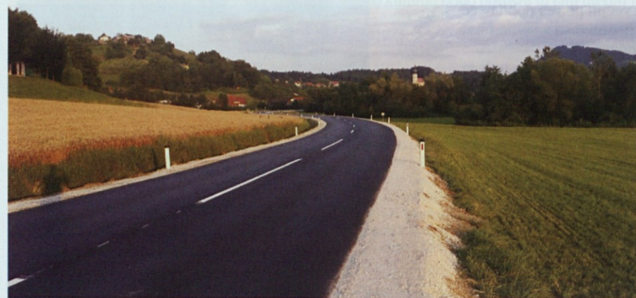
Odsek ceste, ki Šentjur povezuje z avtocesto, so pred kratkim preplastili.
