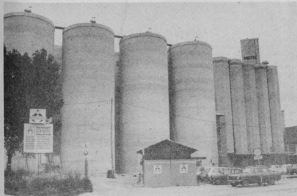
Ob novi celjski pekarni so zgradili tudi dodatne silosne zmogljivosti, tako da bodo sedaj v Celju lahko vskladiščili 28 tisoč ton žita. Takšna količina pa že zadošča za normalno obratovanje pekarnice.
