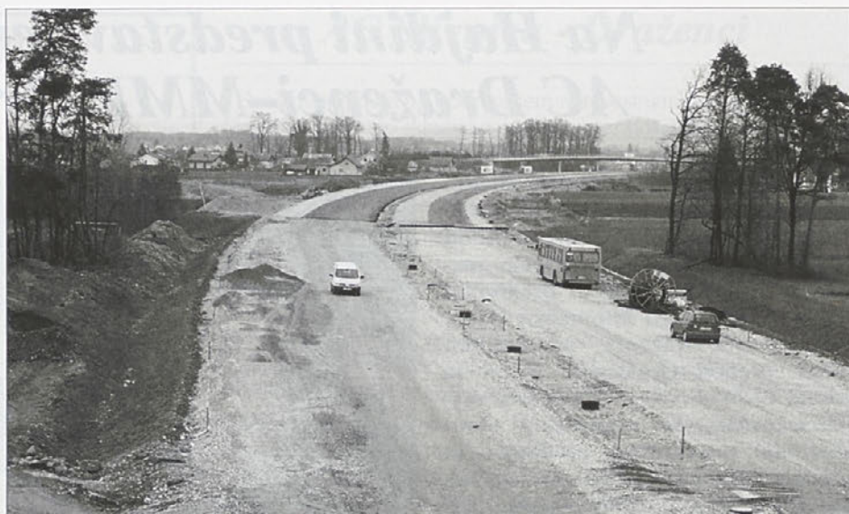
Odsek avtoceste do MMP Gruškovje se bo pričel graditi v Dražencih
