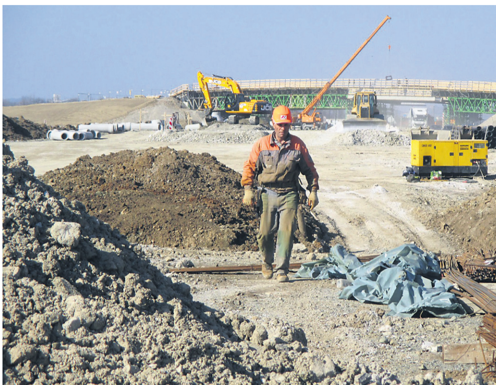
Dela na prvi etapi avtocestnega odseka so v polnem teku.
