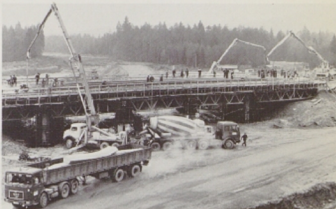
Betoniranje konstrukcije nadvoza preko zahodne obvoznice Ljubljana (foto: Peter Strnad)
