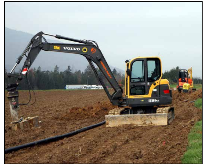
Pri obnovi vodovoda v Podvinu
