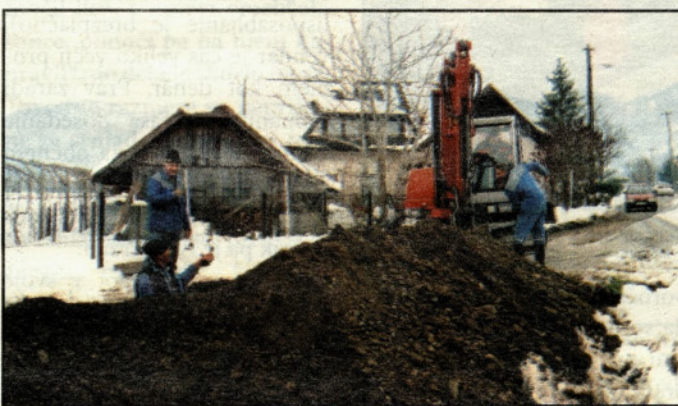
Z izgradnjo kanalizacije nadaljujejo tudi v zimskem času.
