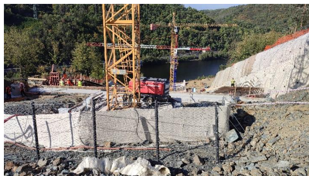
Slika: Izkop, priprava temeljnih tal in pogled na gradbišče v smeri dolvodno (📷 M. Klun).
