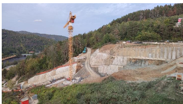
Slika: Gradbišče Orlik s krone pregrade (📷 M. Klun).
