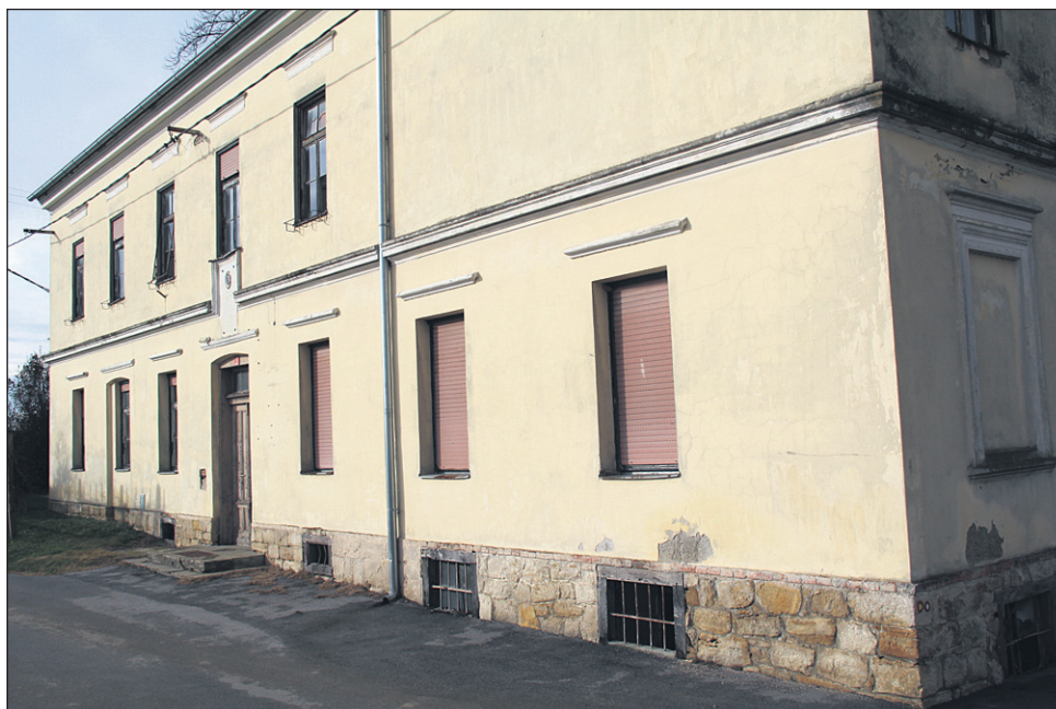
Poslopje nekdanje šole na Humu, ki so ga gasilci konec lanskega leta počistili, pri tem pa domnevno uničili ali poškodovali umetnikovo lastnino.
