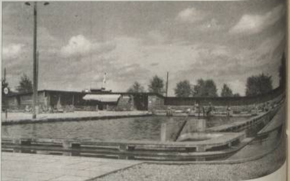
Pogled na zaokrožene vogale velikega bazena.
