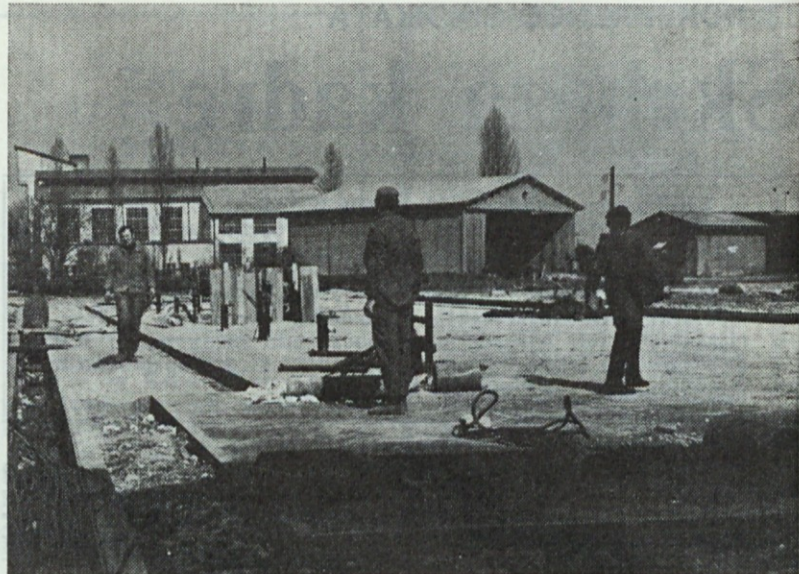
Novi plato ob pločevinarni. Tu bomo sestavljali zvarjenice velikih mer
