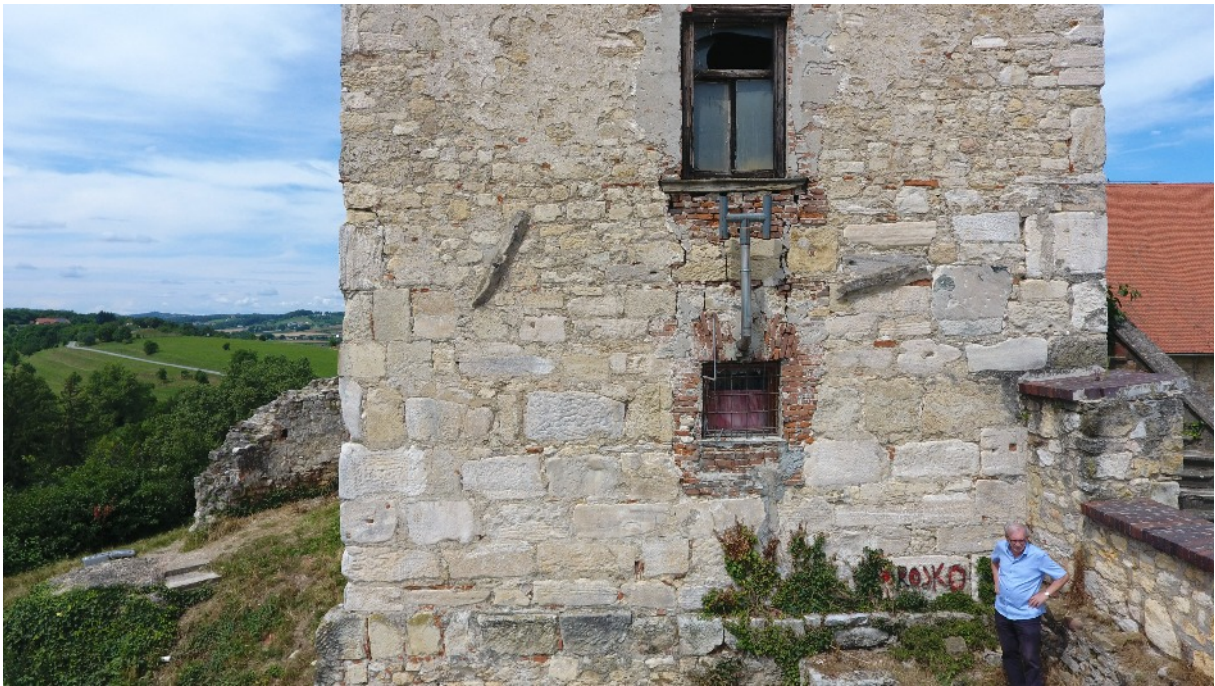
Slika 1. Vzhodna fasada zahodnega stolpa Ptujkega gradu, zgrajenega iz marmornih spolij
