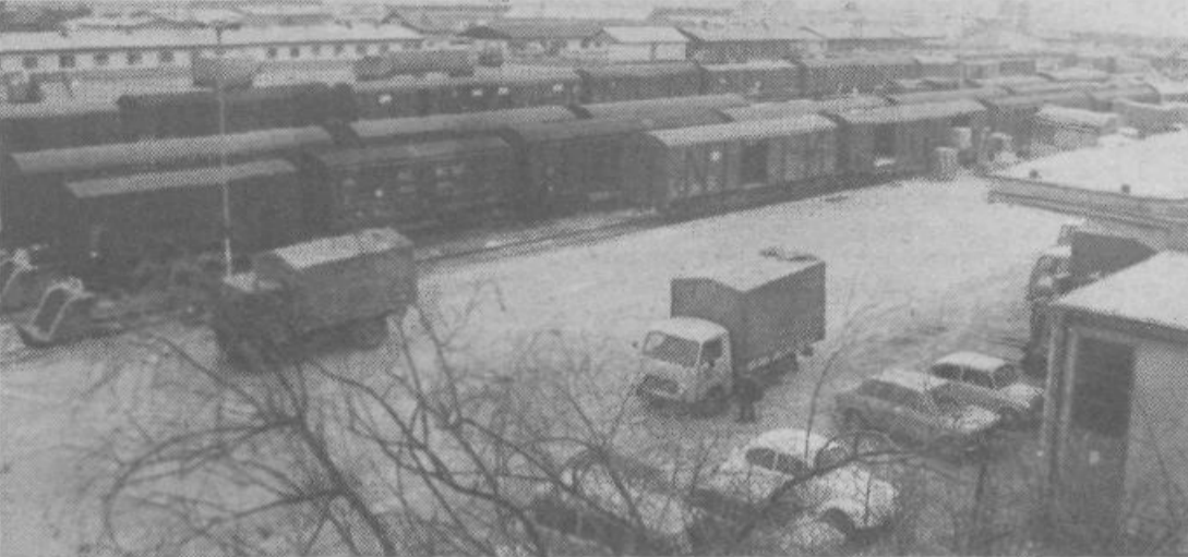
Pogled na železniško tovarno postajo v Mostah (Foto: Arhiv Tozda za transport Moste)
