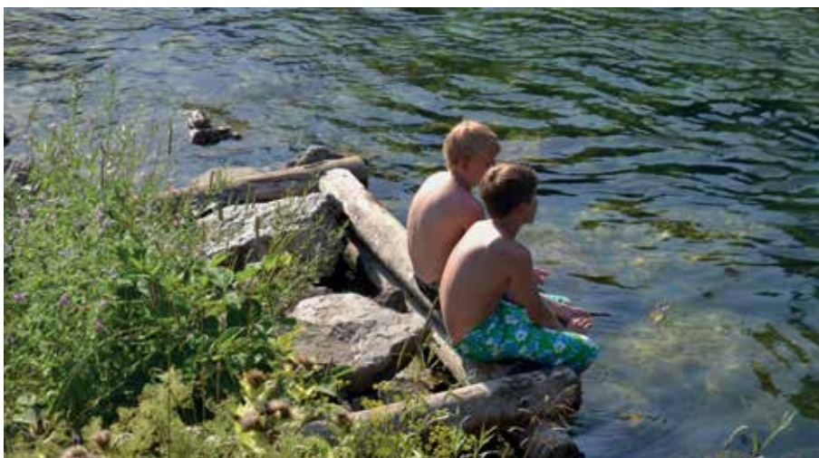
Slika 2: Zavarovanje obrežja s kranjsko steno na Savi Bohinjki. Ureditev je prijazna do vodnega in obvodnega habitata ter privlačna za rekreacijo. (avtor fotografije: M. Bricelj)
