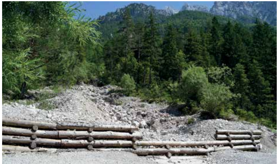
Slika 3: Pišnica – pot v Krnico. Uporaba tehnike kranjske stene za varovanje poti na izjemno dinamični hudourniški podlagi. (avtor fotografije: M. Bricelj)
