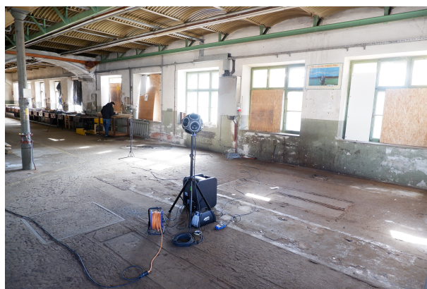
Slika 1: Fotografija v času opravljanja meritev v spraznjeni industrijski hali KČB.
