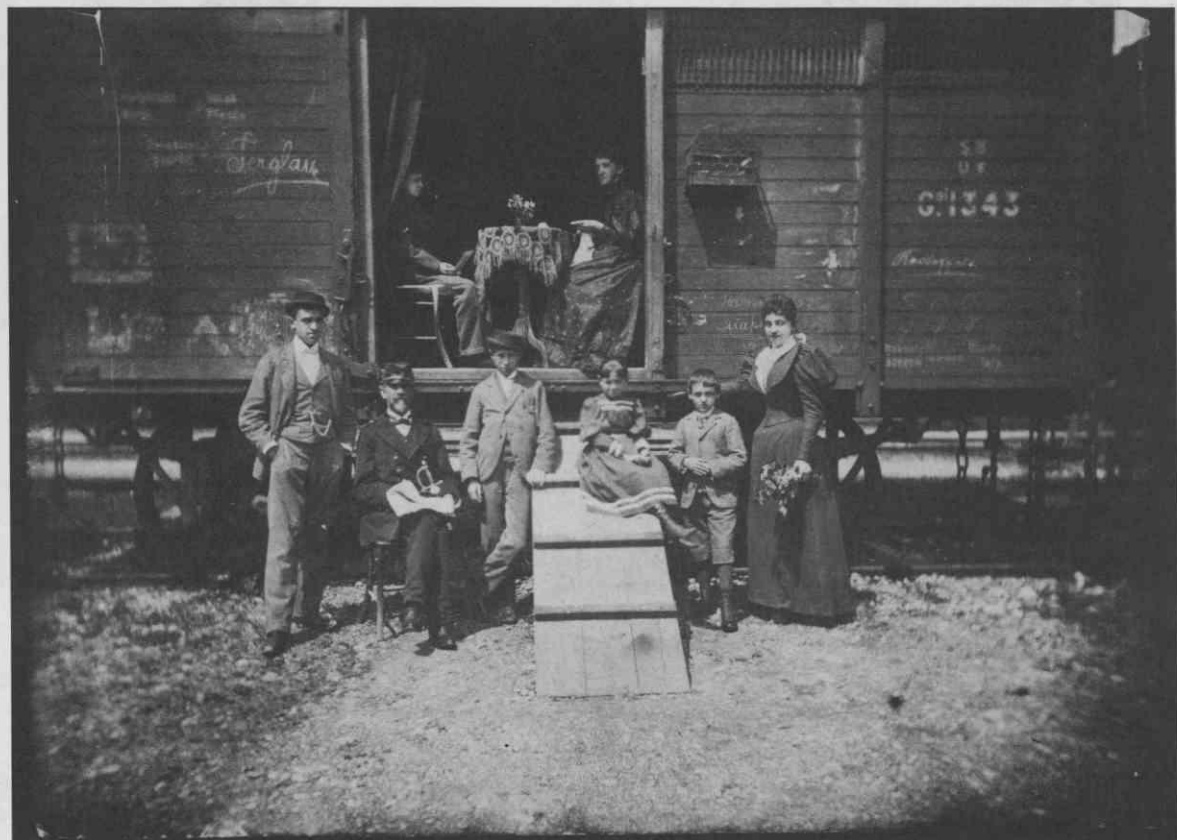
Zasilno bivališče v vagonu
