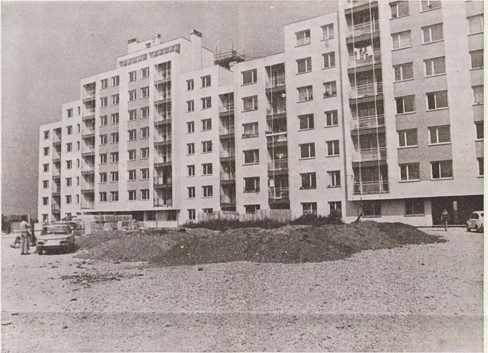
V novih Jaršah v Ljubljani raste nova in velika stanovanjska četrt, pri izgradnji pa sodeluje tudi naše podjetje
