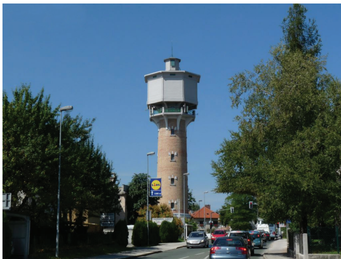
Slika 31. Vodovodni stolp v Kranju [Wikipedia, 2023d].
