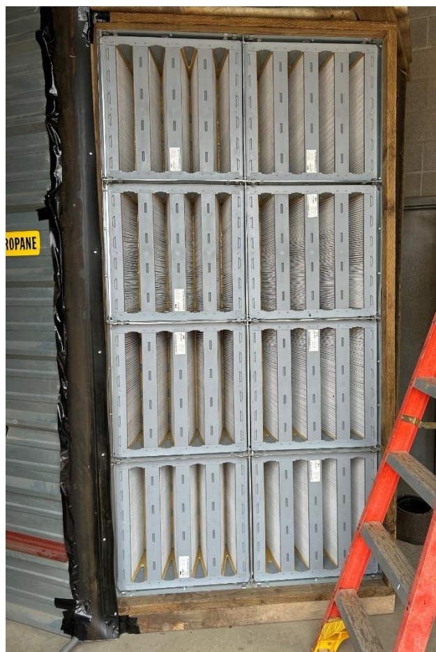
Nameščeni protidimni adsorpcijski filtri na vходу zraka v sušilnico (Foto: I. J. Košir)
