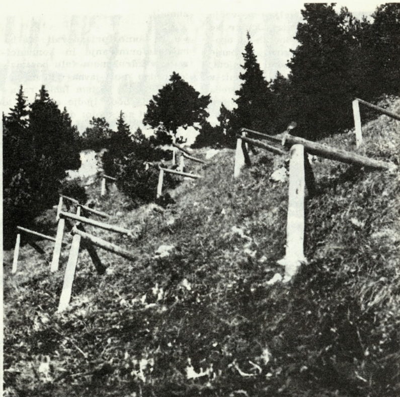
Enostavno zavarovanje pogozdenih brežin pred snežnimi plazovi v visokogorskih predelih kneževine Lichtenstein
