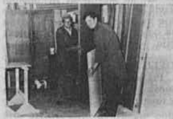
Naši prostori so spet temeljito obnovljeni. Za to pa so potrebne predhodne priprave
