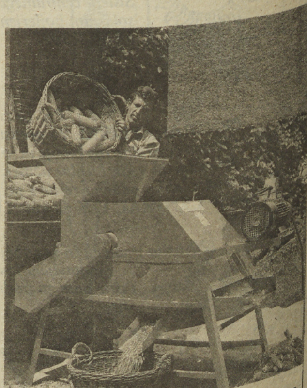
• Luščilec koruze namenjen za luščenje suhega storža. Pri optimalnem polnjenju je največja zmogljivost 3.500 kg na uro.
