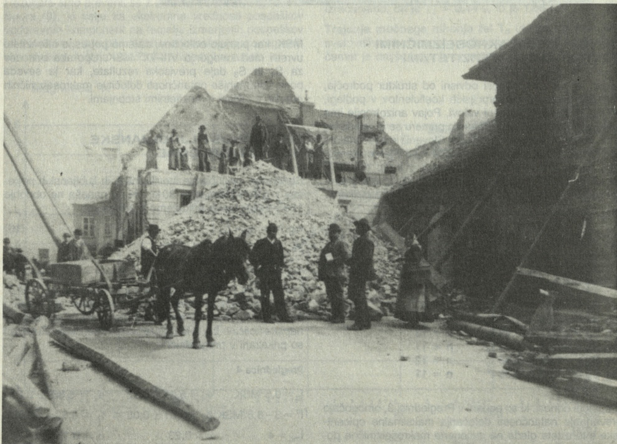
Slika 6. Obnovitvena dela v Ljubljani. Nekaj hudo poškodovanih objektov je bilo potrebno porušiti.
