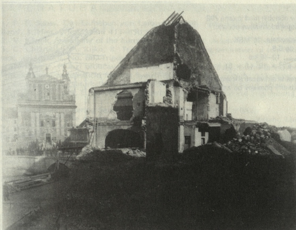
Slika 4. Porušen objekt v Špitalski 11, danes Stritarjevi ulici.
