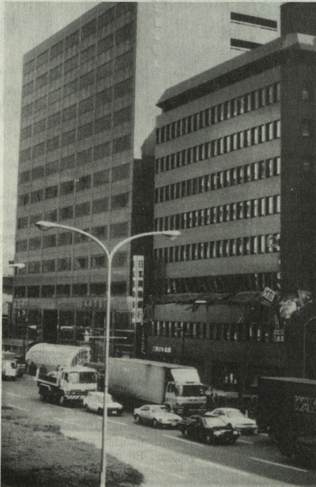
Slika 11. Nova armiranobetonska stavba (na levi) je ostala nepoškodovana, medtem ko je starejša (na desni) izgubila tretjo etažo).
